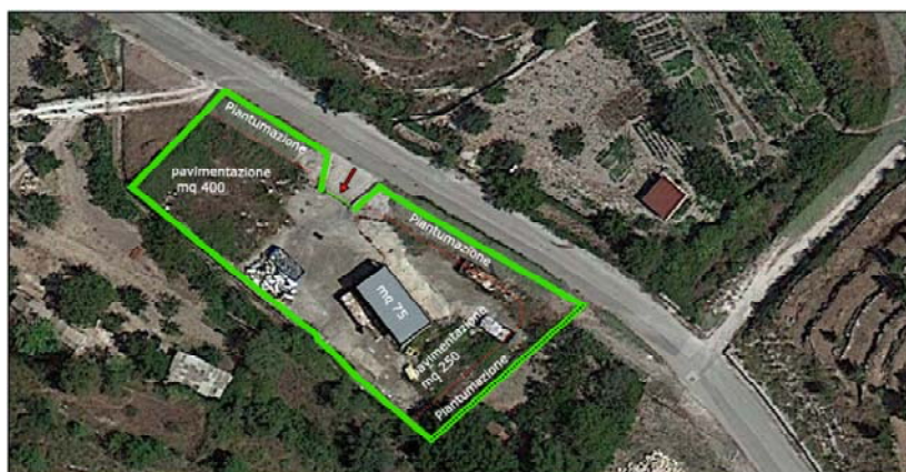
Figura 40 Stato di fatto del Centro Comunale di Raccolta
