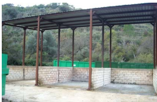
Figure 32/33 CCR del Comune di Monterosso Almo (condizioni di degrado dell'impianto)
